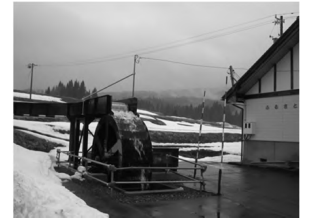
小水力発電(大)〔上掛け水車型、750ワット、落差3m〕
